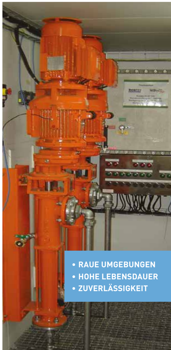
Ölbohranlage: Regelgetriebe an Schraubspindel-pumpe (Atex-Zone)
