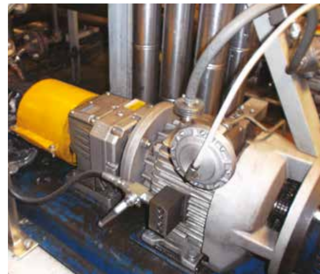
Impianto chimico: variante K5 con controllo remoto pneumatico
