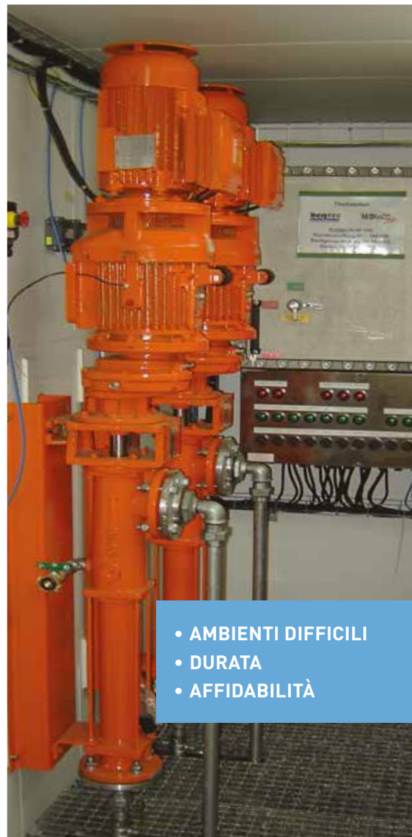
Impianto trivellazione petrolio: variatori di velocità su pompa a vite (ambiente ATEX)
