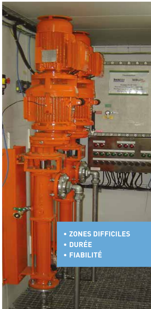
Installation de forage de pétrole : variateurs de vitesse sur pompe à vis (zone ATEX)
